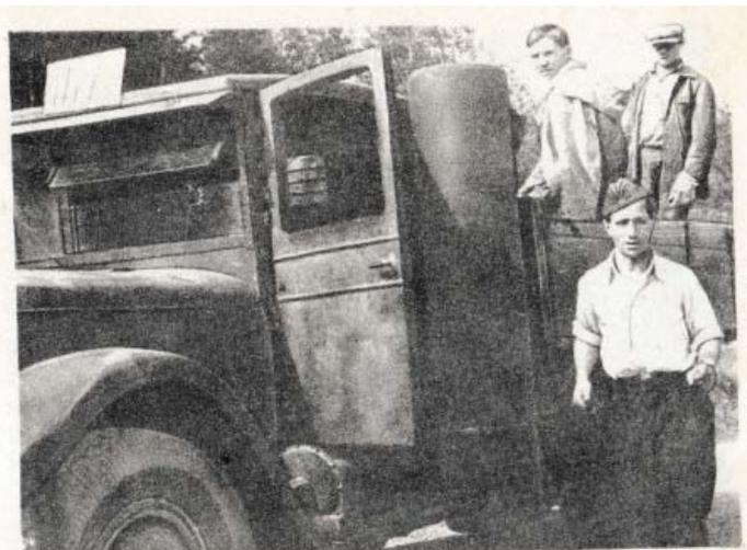
**На трассе Эге-Хая – Батамай (ЗИС-5 – трёхтонка).** Двигатель работал не на бензине (где его взять?), а на генераторном газе, т.е. на щепках (топливо доступное). Зимой в кузове была печь с дровами, иначе - хана). на переднем плане шофер Ю.Г.Шефер - в будущем доктор физмат наук, лауреат Государственной премии СССР.
