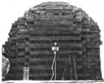
Рис. 215. Одна из пяти уран-графитовых сфер первого советского ядерного реактора (Ф-1)
