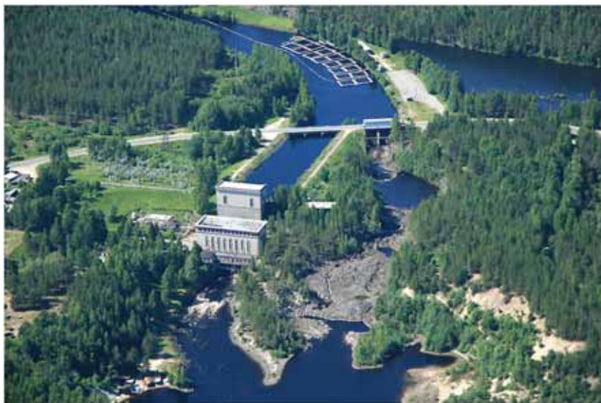
Кондопожская ГЭС на реке Суна в районе водопада Гирвас.
