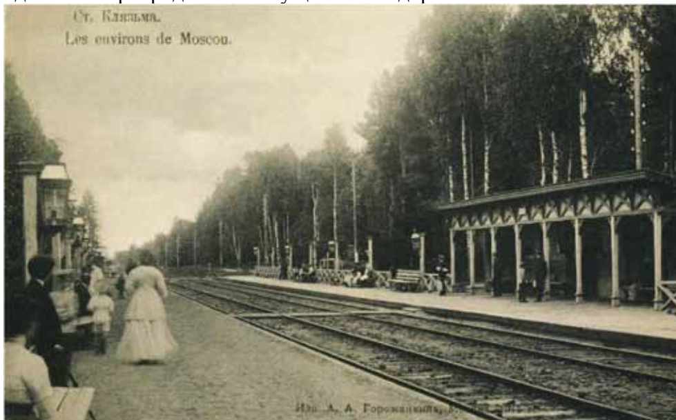
Станция Клязьма Северной железной дороги.
