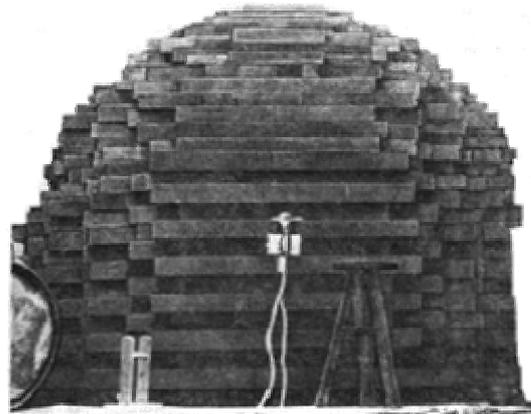
**Рис. 3.** Одна из пяти уран-графитовых сфер первого советского ядерного реактора (Ф-1)
