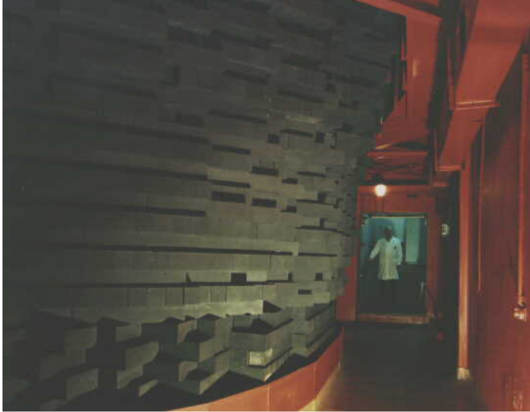
Рис.1 Графитовая кладка первого в Европе исследовательского реактора «Ф-1»
