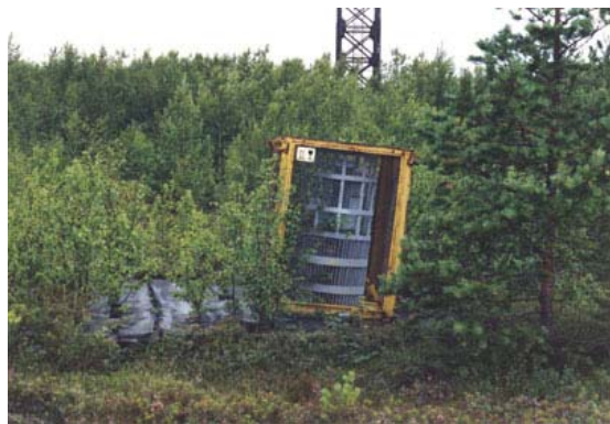
Рис.5 РИТЭГ советского производства на удалённом маяке.
