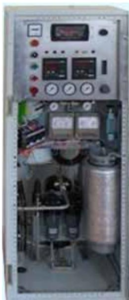
**Рис. 1.** Мембранный генератор, много лет снабжающий чистым азотом Химфак МГУ.
